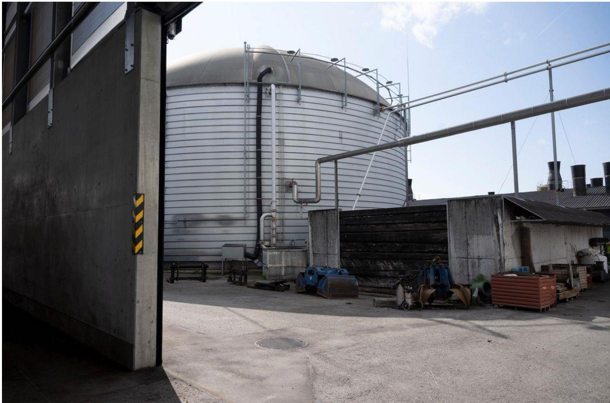
*Le méthaniseur d'Axpo Biomasse à Chavornay alimente l'équivalent de 1500 ménages en énergie électrique et 1000 en thermique grâce à un coupleur chaleur-force.*
